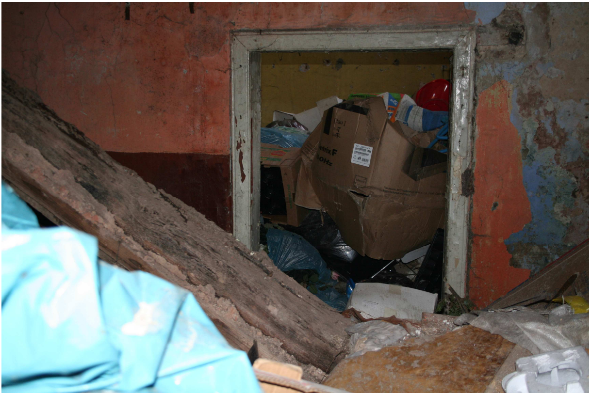
Fot. 4 – Parter budynku mieszkalnego – widoczne znaczne zagruzowanie
