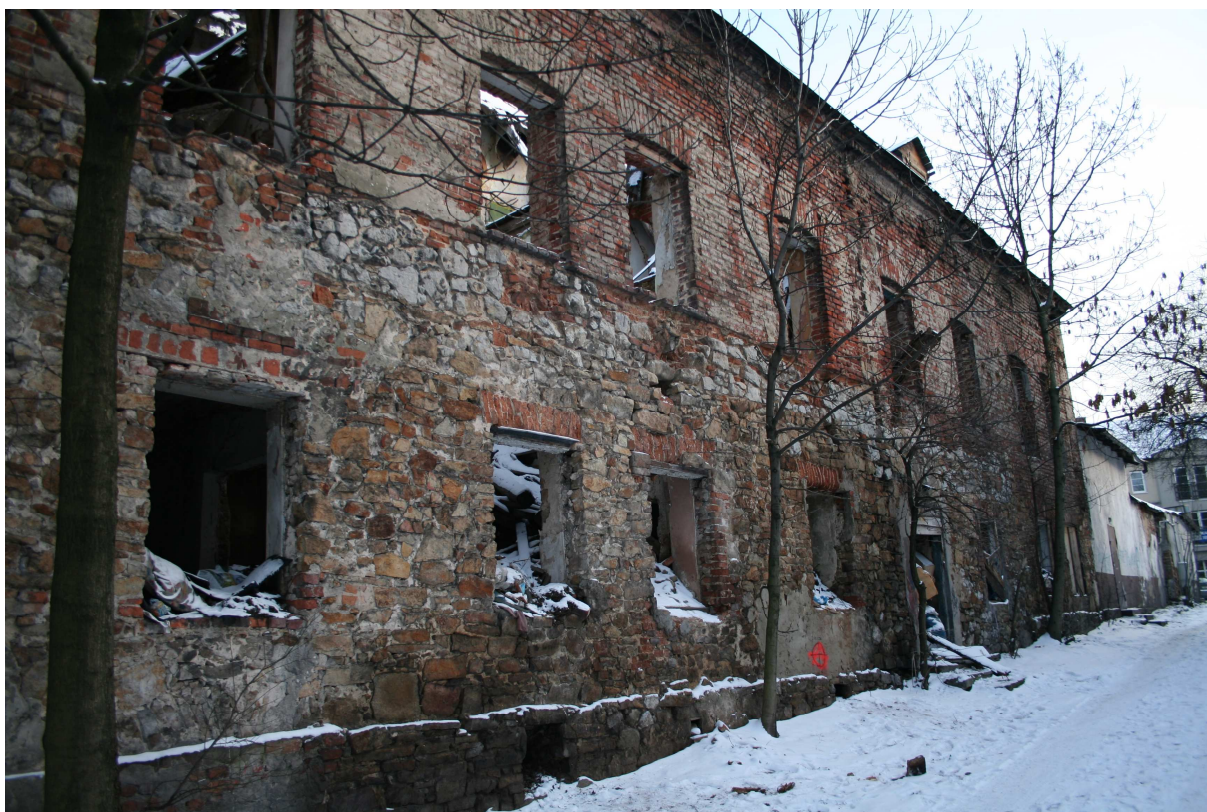
Fot. 1 – Widok ogólny budynku mieszkalnego
