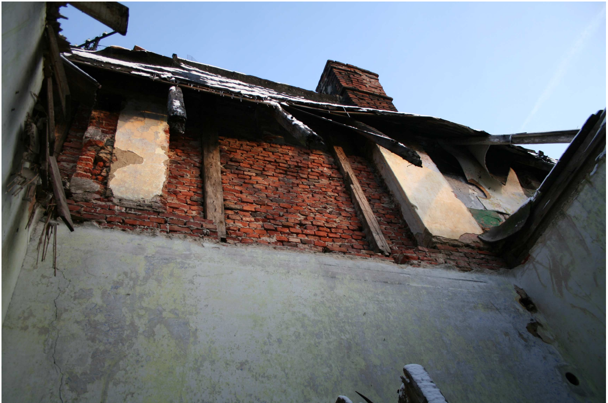
Fot. 3 – Budynek mieszkalny – zawalony dach i strop poddasza
