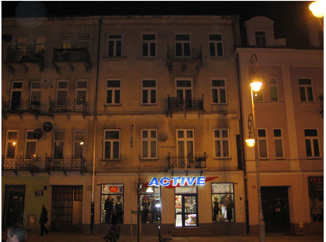
Zdjęcie 3 – ELEWACJA POŁUDNIOWO - ZACHODNIA - stan istniejący
