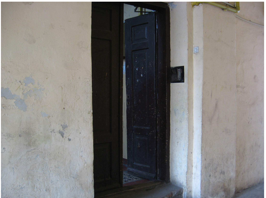
Zdjęcie 6 – WEJŚCIE NA KLATKĘ SCHODOWĄ - stan istniejący
