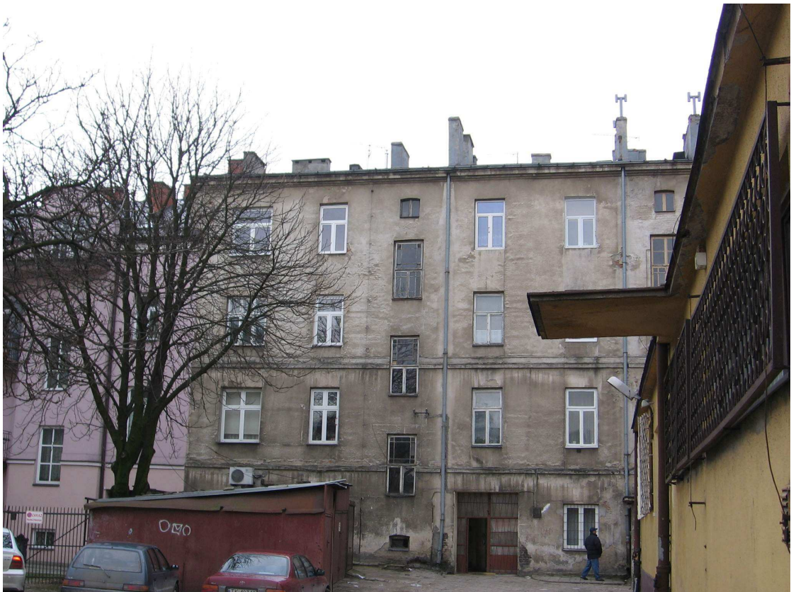
Zdjęcie 8 –ELEWACJA PÓŁNOCNO – WSCHODNIA - stan istniejący
