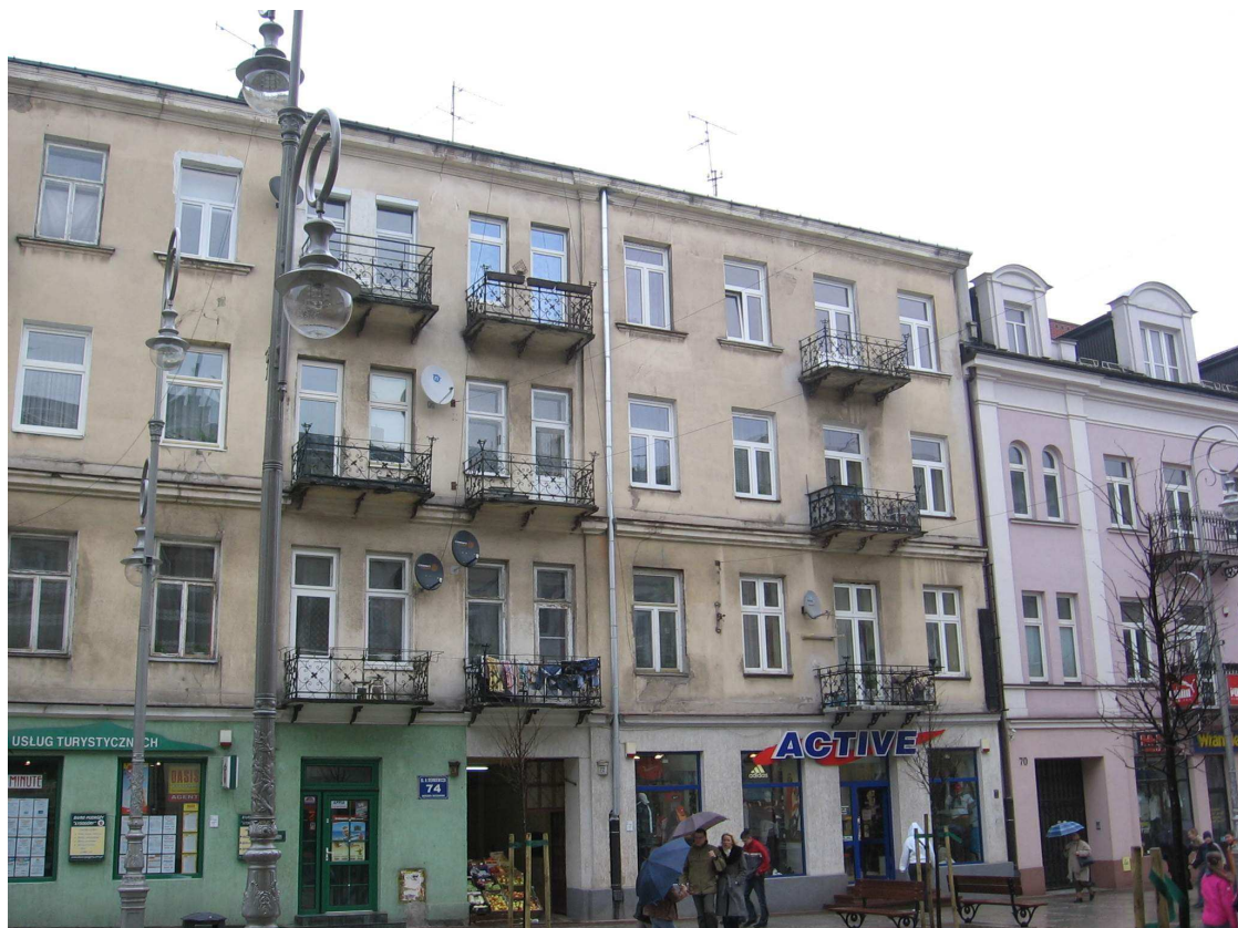
Zdjęcie 1 – ELEWACJA POŁUDNIOWO - ZACHODNIA - stan istniejący
