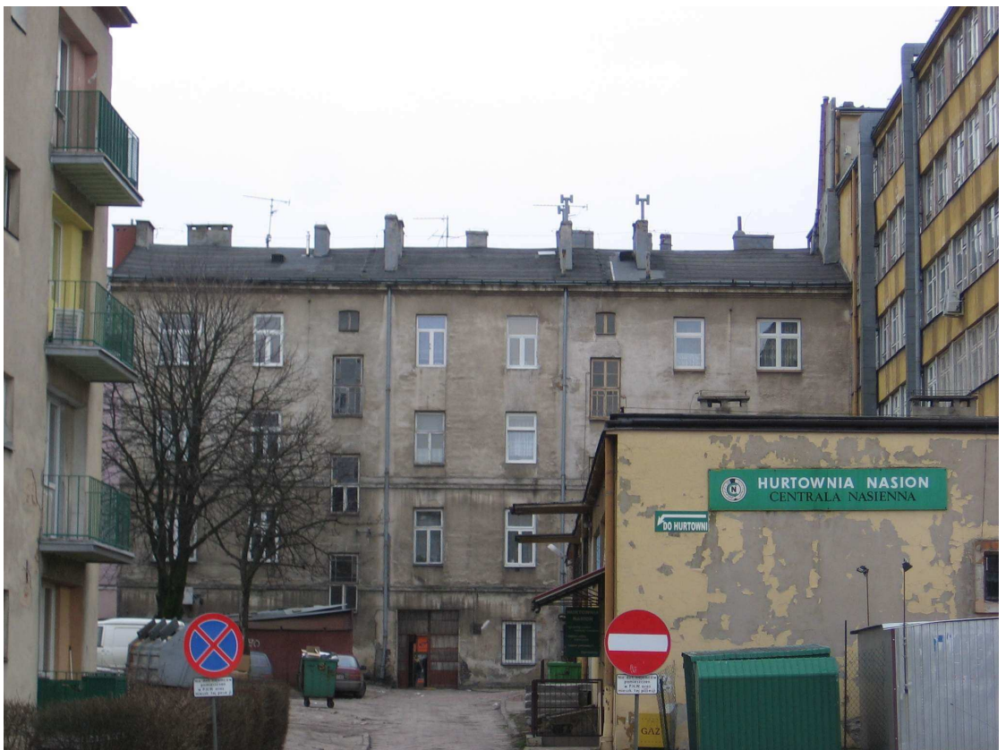
Zdjęcie 10 –ELEWACJA PÓŁNOCNO – WSCHODNIA - stan istniejący
