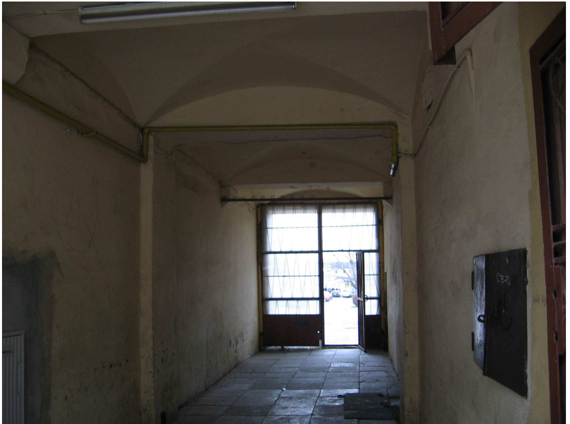
Zdjęcie 5 – BRAMA PRZEJAZDOWA - stan istniejący
