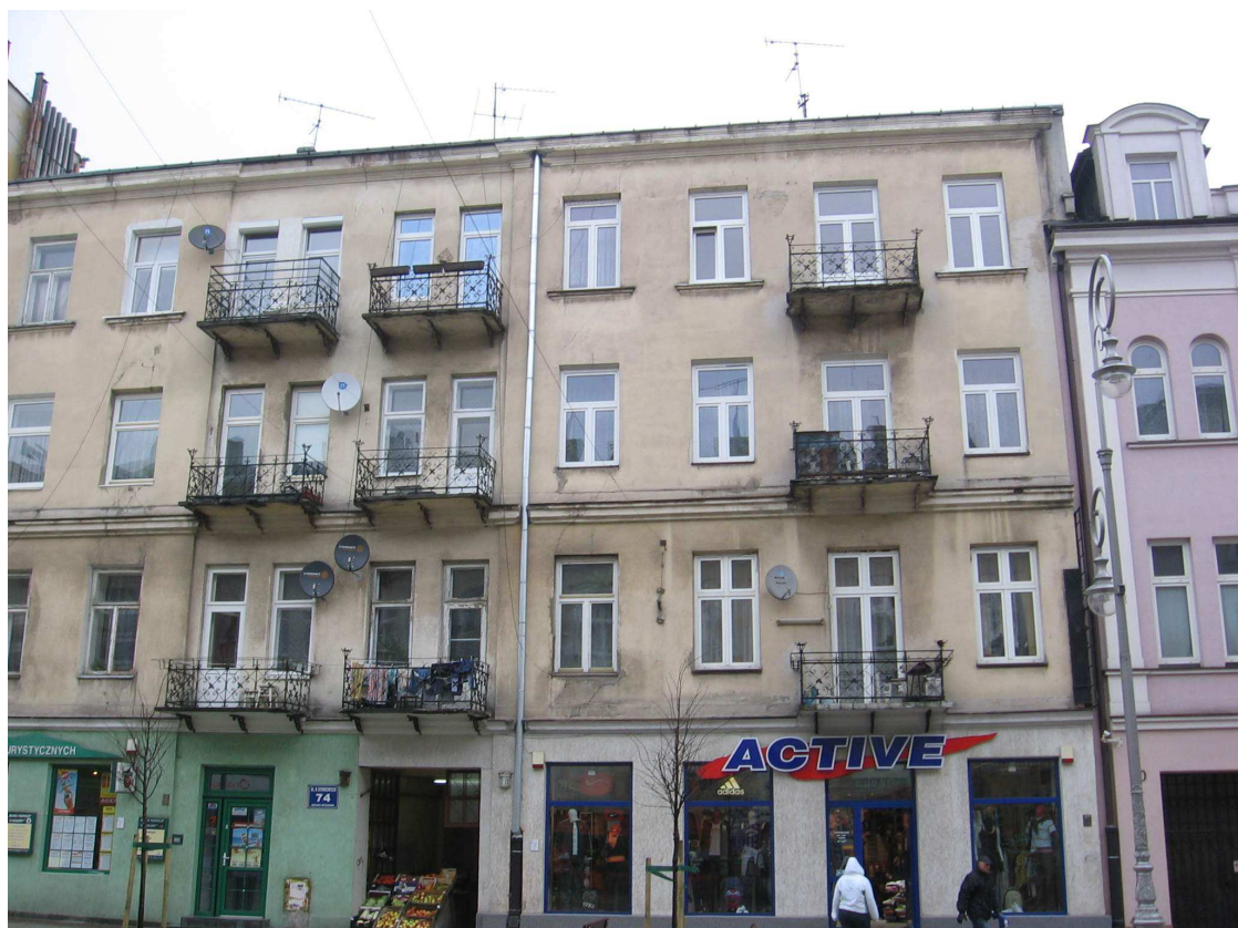
Zdjęcie 2 – ELEWACJA POŁUDNIOWO - ZACHODNIA - stan istniejący
