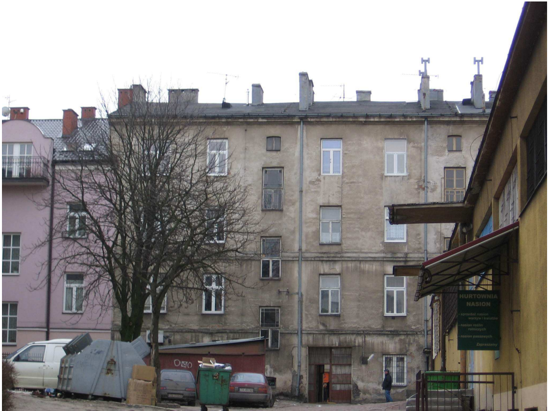
Zdjęcie 9 –ELEWACJA PÓŁNOCNO – WSCHODNIA - stan istniejący
