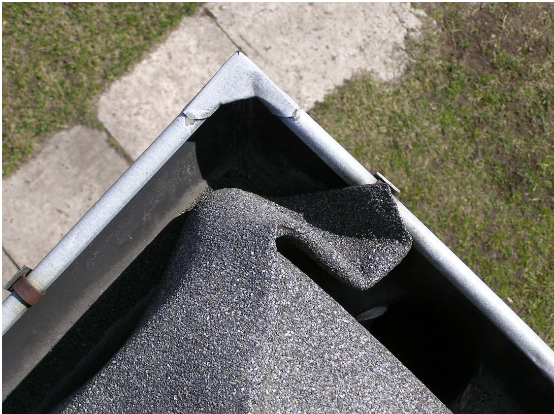
Wadliwe wykonanie pokrycia dachu
