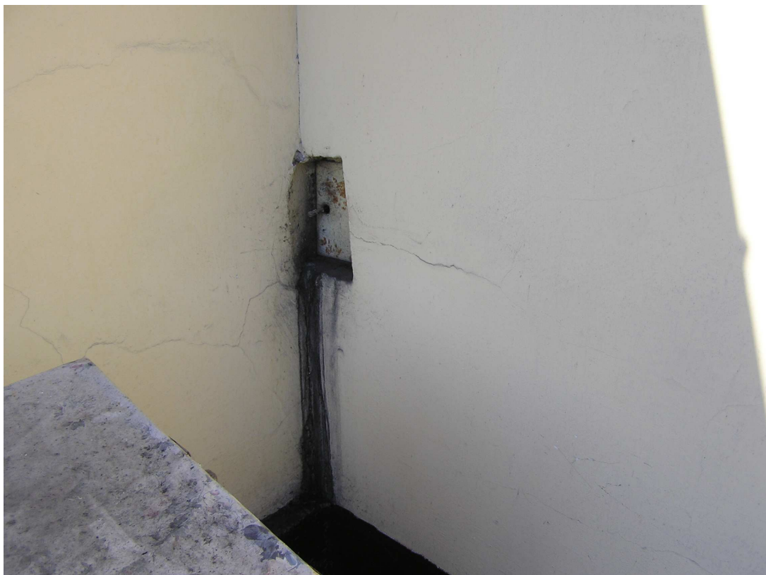
Osad po wydobywaniu sadzy na elewacji południowej
