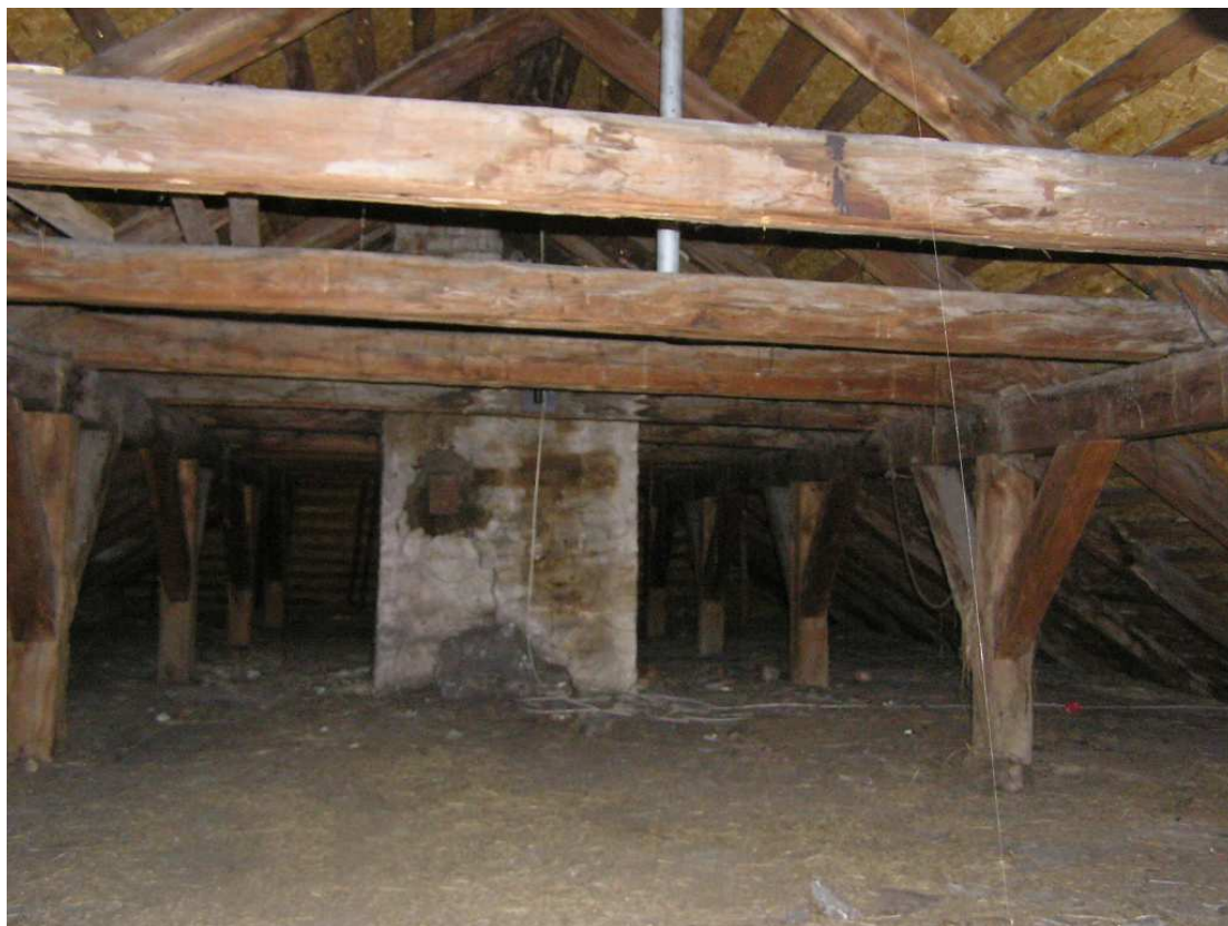
Widok na poddasze nieużytkowe
