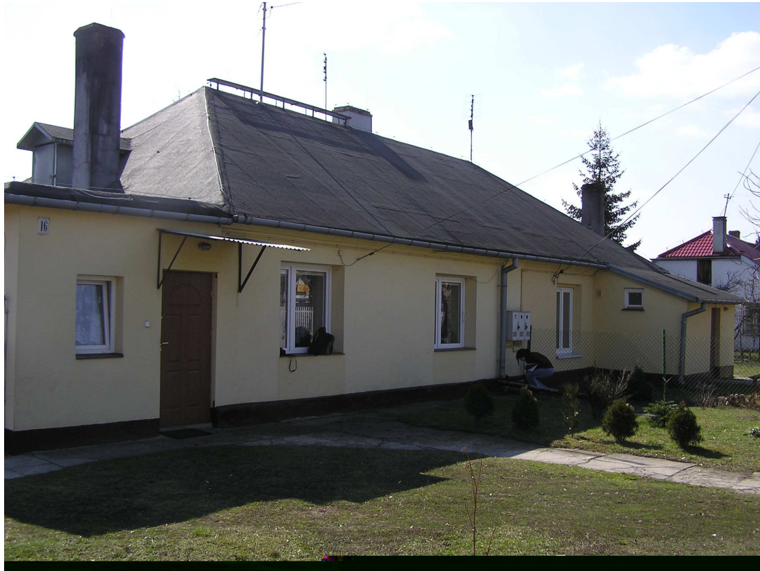
Widok na elewację północną
