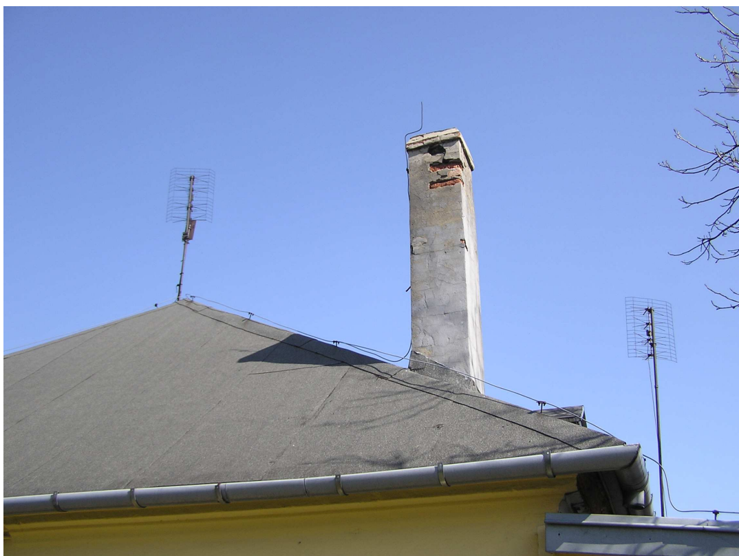
Widok na komin od strony zachodniej (zły stan techniczny)
