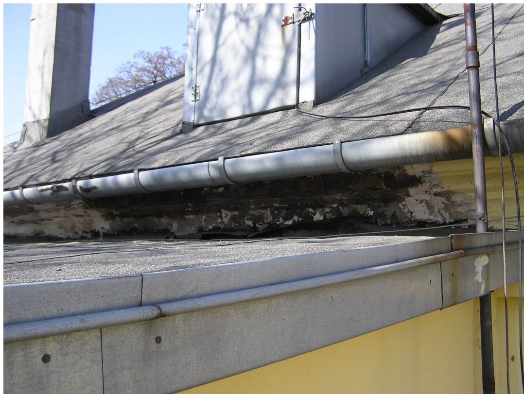
Zawilgocony tynk w miejscu połączenia dobudówki ze ścianą zewnętrzną budynku
