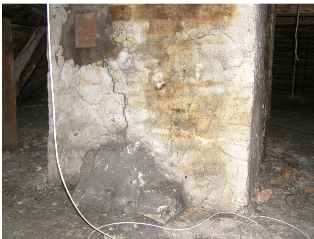
Widok na komin na poziomie poddasza (bardzo zły stan techniczny)
