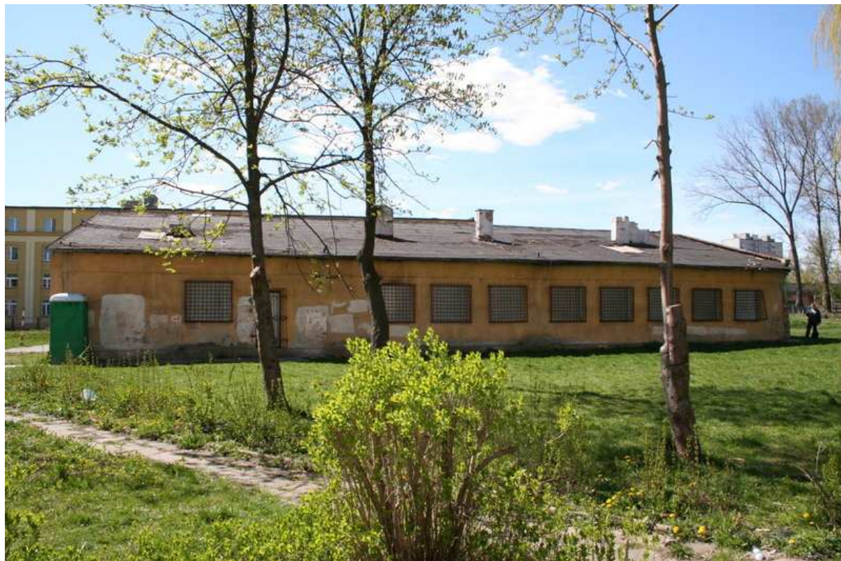
Fot. 1 – Widok budynku od strony ulicy Chałubińskiego
