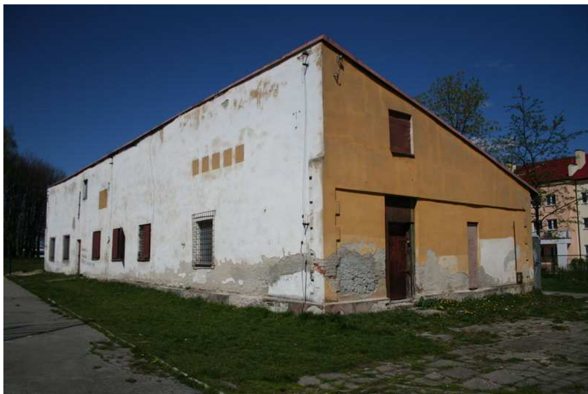
Fot. 2 – Widok budynku od strony południowej
