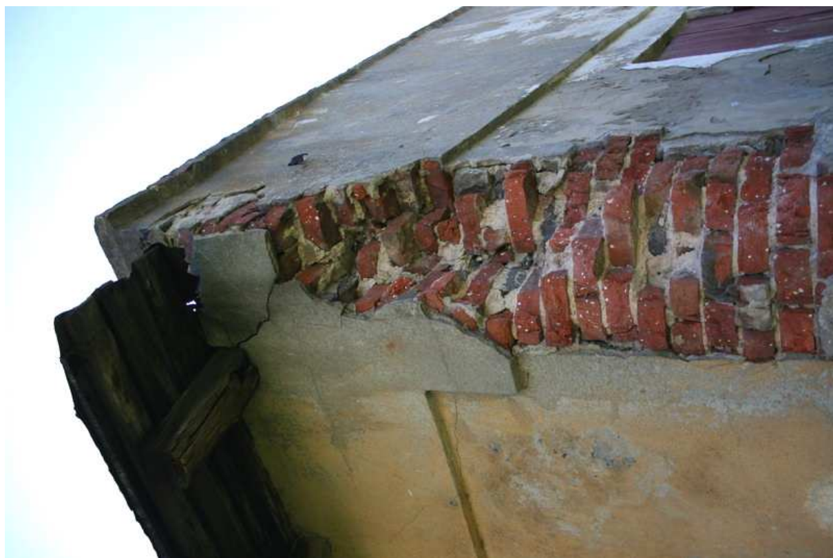
Fot. 4 – Szczegół więźby dachowej oraz narożnik ściany zewnętrznej
