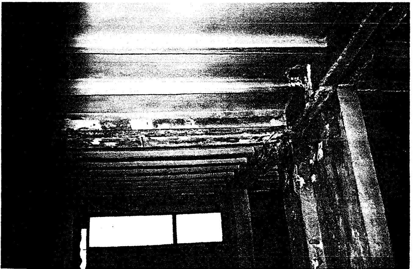
Fot. 4. Widok wnętrza obiektu oraz stropodachu
