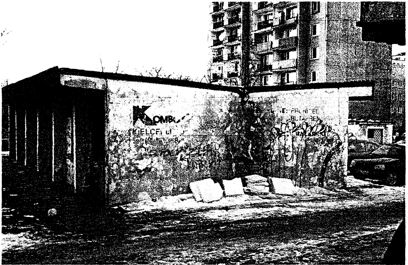
Fot. 3. Widok ściany szczytowej
