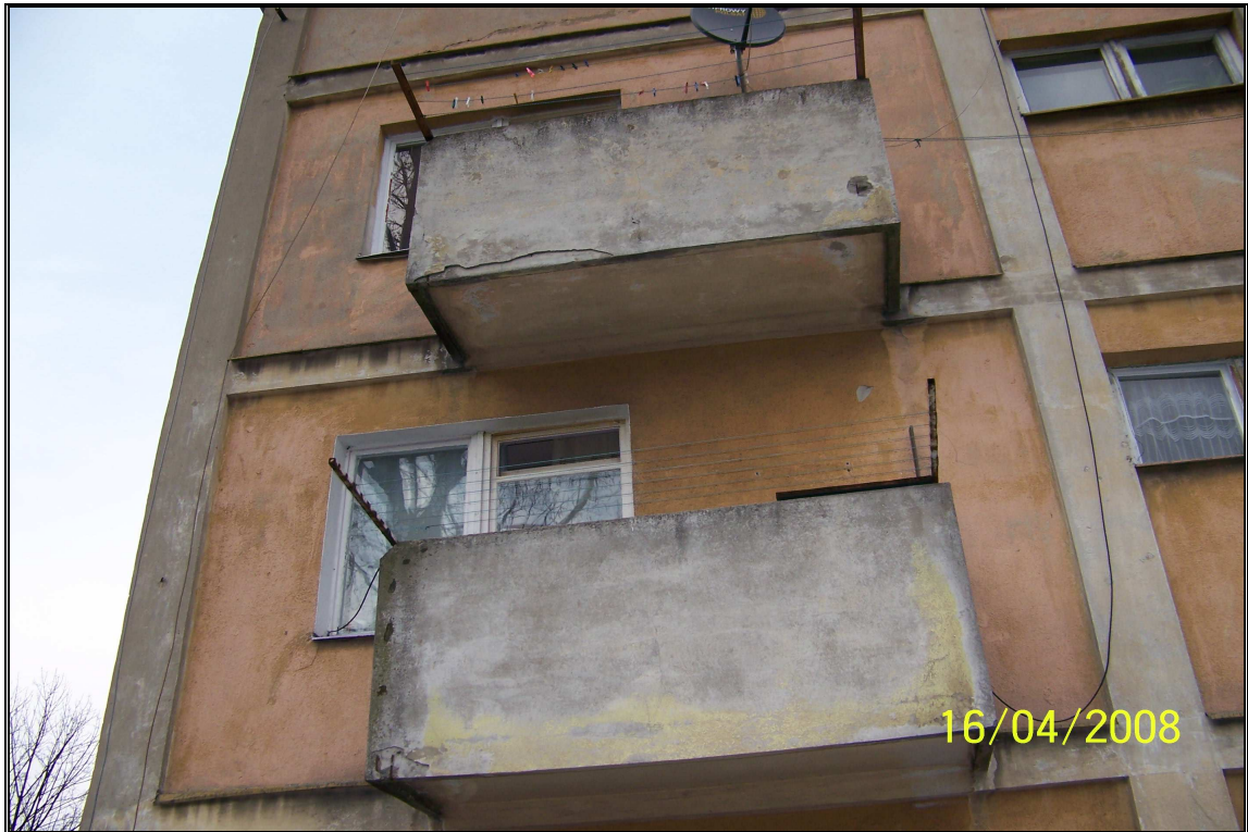
Fot.5 Balkon nr 9 i 10
