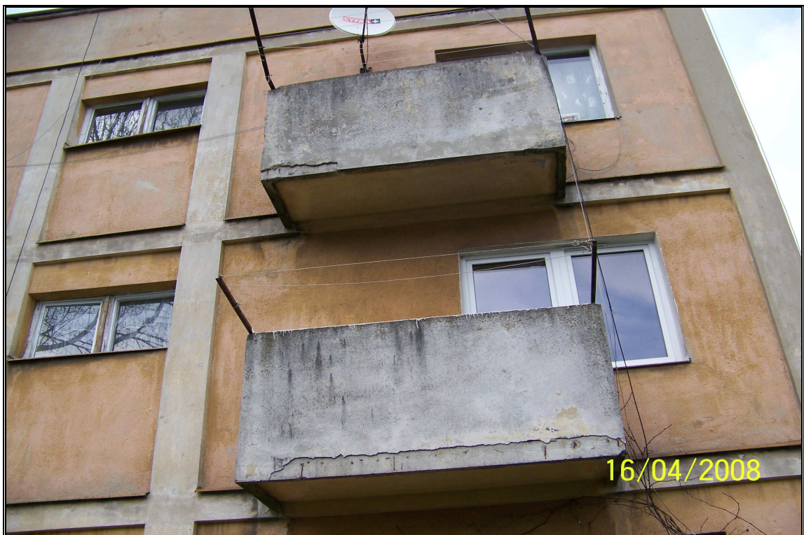
Fot.6 Balkon nr 11 i 12
