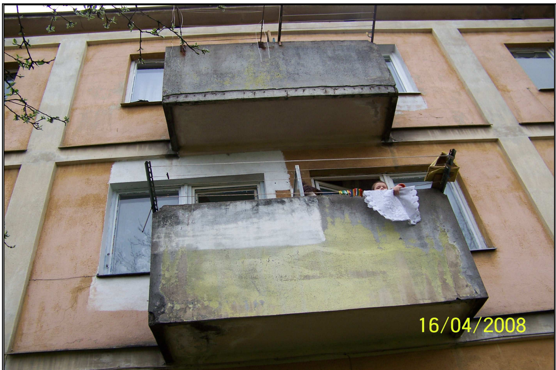
Fot.10 Balkon nr 19 i 20
