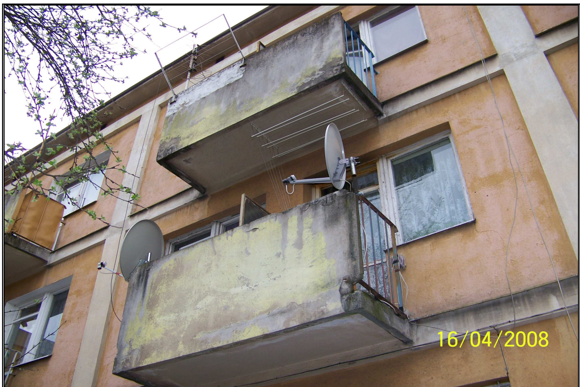
Fot.8 Balkon nr 15 i 16
