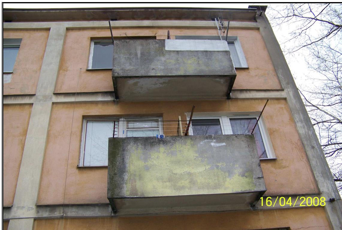
Fot.11 Balkon nr 21 i 22
