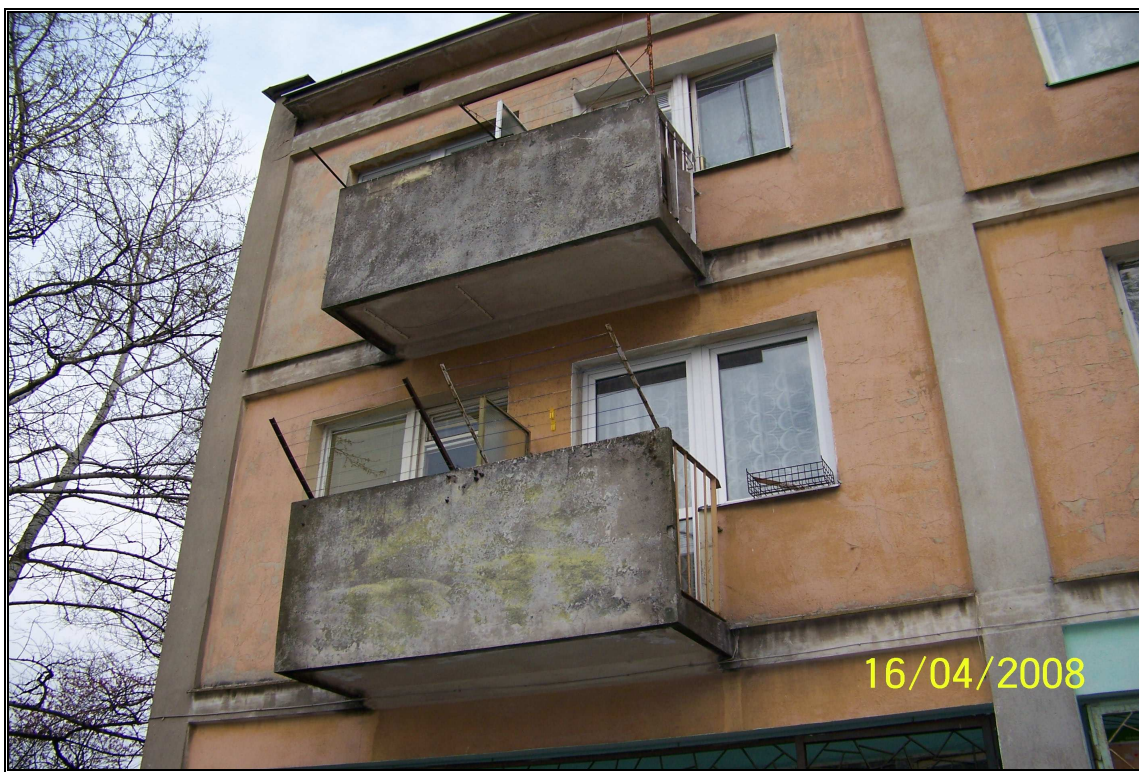
Fot.1 Balkon nr 1 i 2
