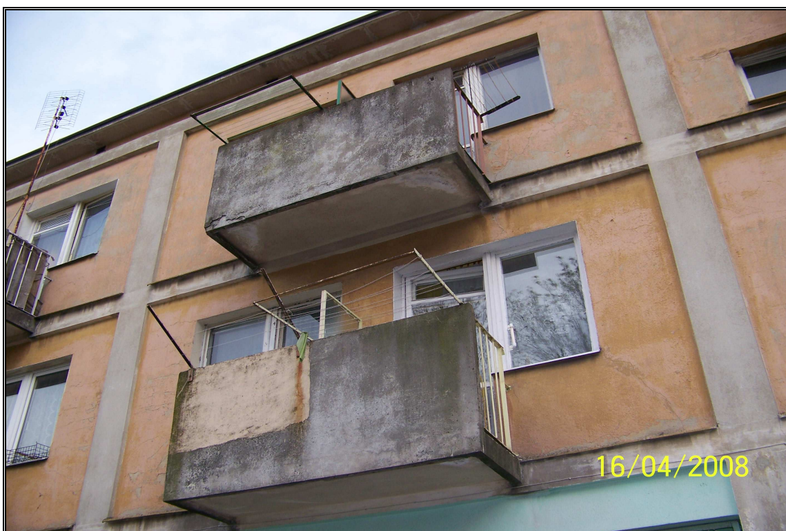
Fot.2 Balkon nr 3 i 4
