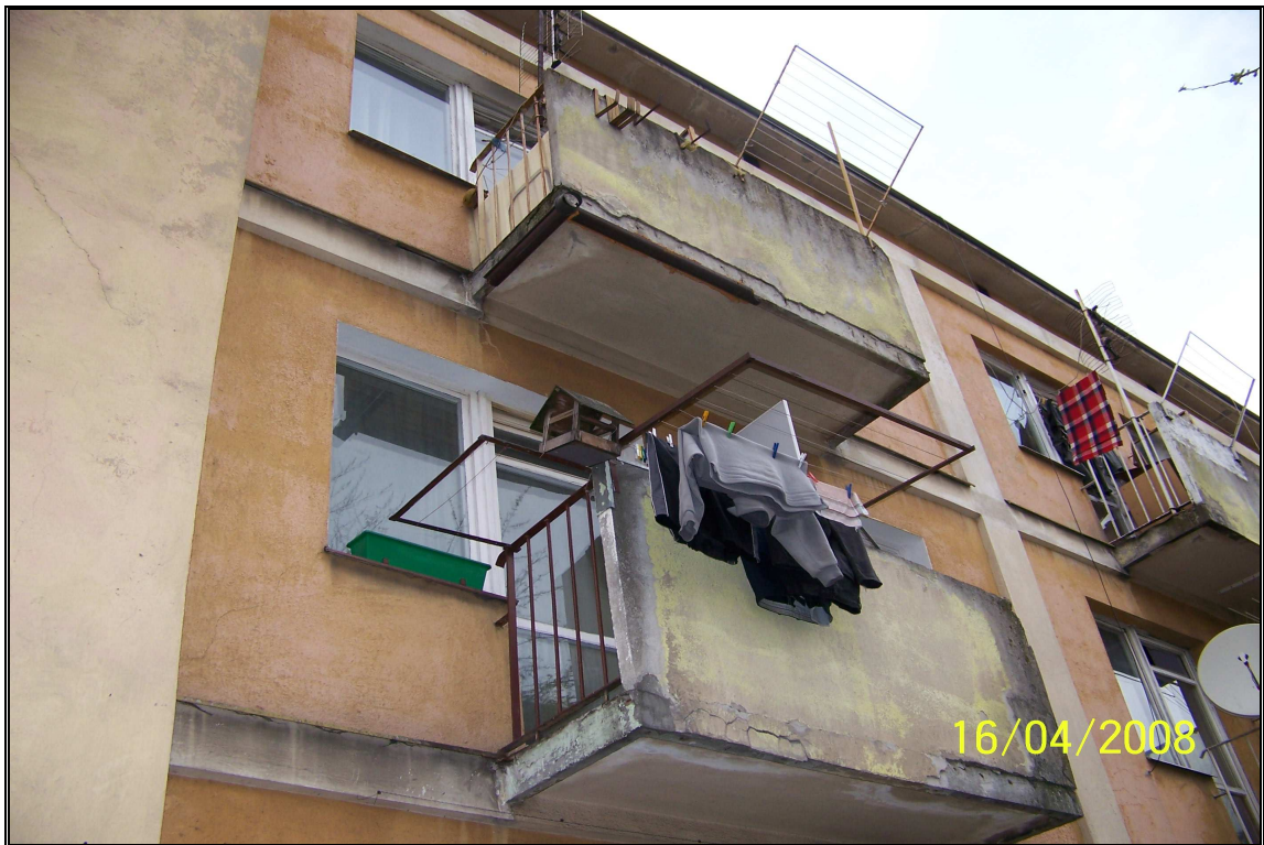
Fot.7 Balkon nr 13 i 14
