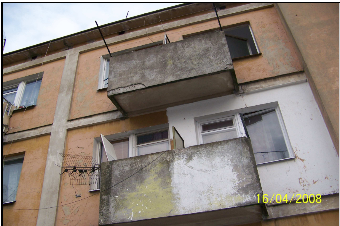
Fot.4 Balkon nr 7 i 8
