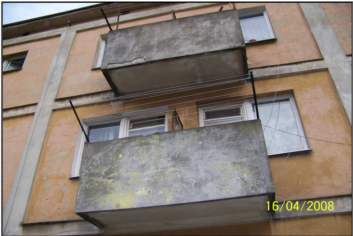
Fot.3 Balkon nr 5 i 6
