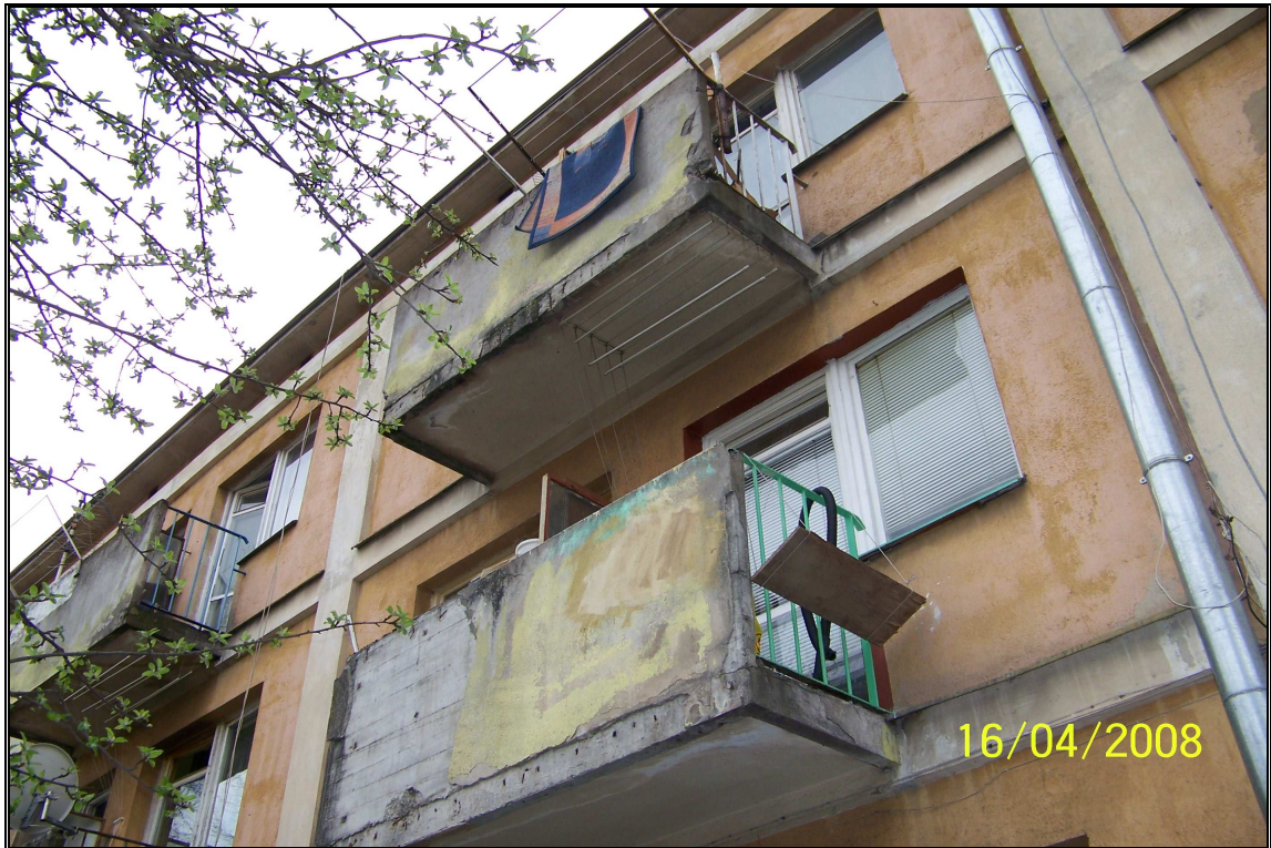
Fot.9 Balkon nr 17 i 18
