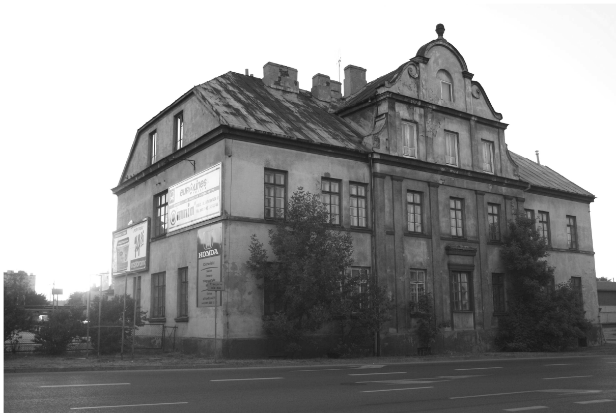
Fot. 1 - Widok budynku od strony hotelu
