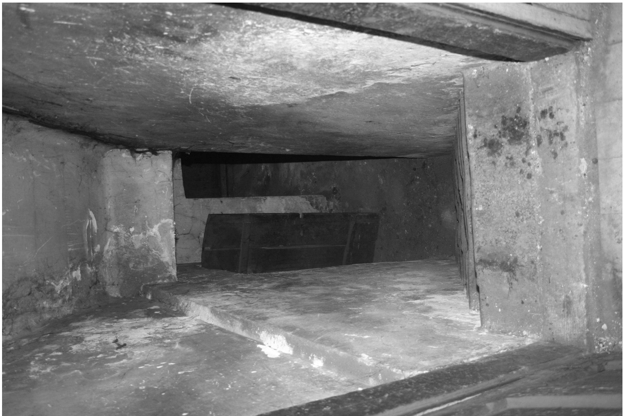
Fot. 8 - Schody do piwnicy
