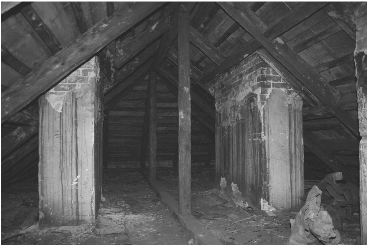
Fot. 4 - Strych – więźba dachowa i kominy
