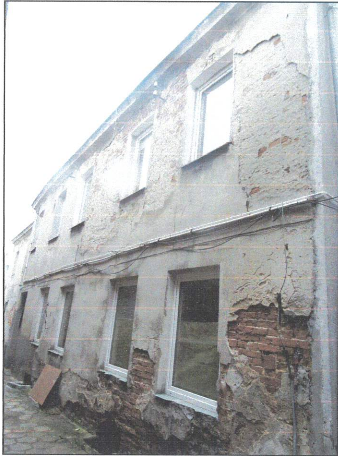
Zdj. Nr 33 Oficyna - elewacja zachodnia
