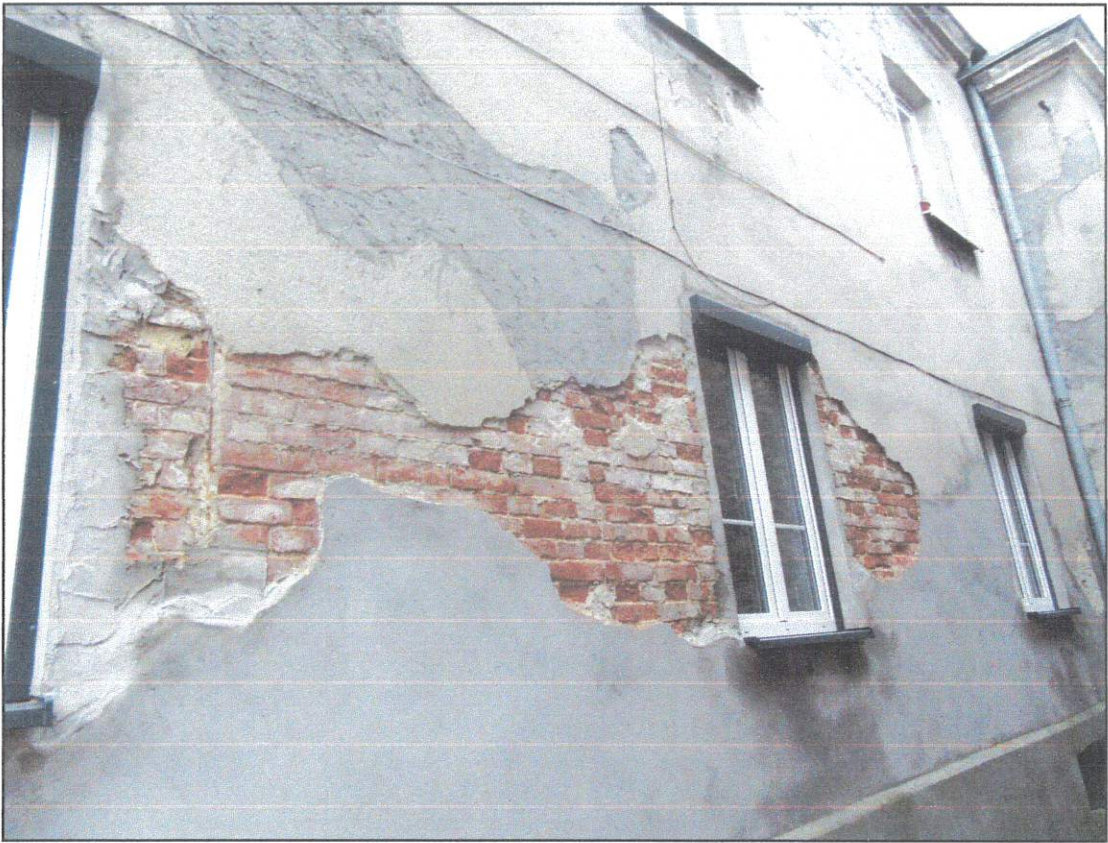
Zdj. Nr 35 Oficyna - elewacja zachodnia
