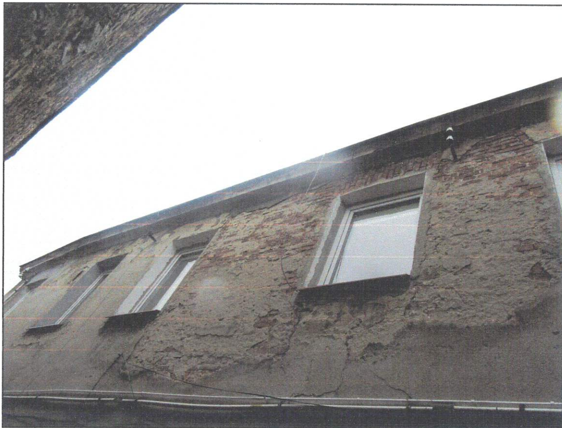
Zdj. Nr 34 Oficyna - elewacja zachodnia
