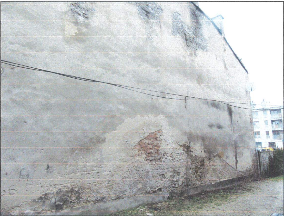
Zdj. Nr 36 Oficyna - elewacja wschodnia
