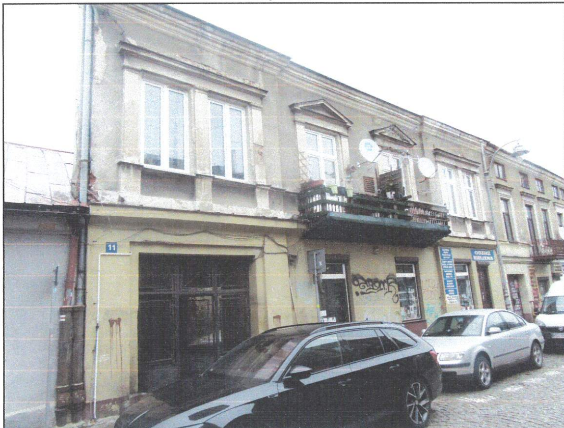
Zdj. Nr 28 Budynek główny - elewacja południowa
