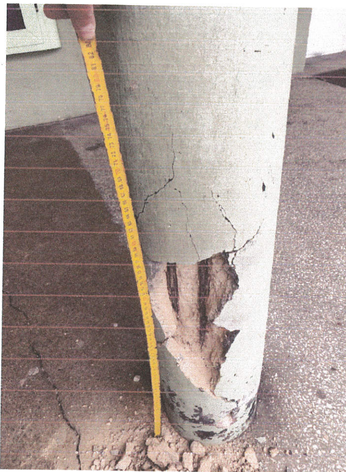
Zdj. Nr 7 Widok wykonanej odkrywki słupa Nr 2
