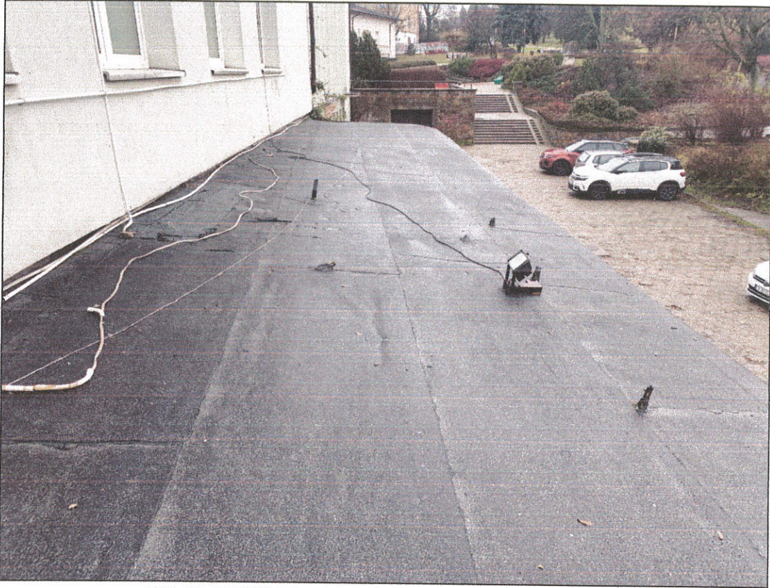
Zdj. Nr 17 Widok pokrycia z papy płyty zadaszienia
