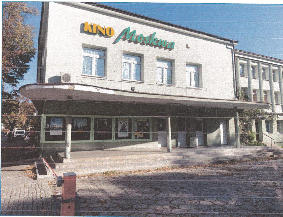
Zdj. Nr 1 Widok zadaszzenia nad wejściem głównym do budynku
